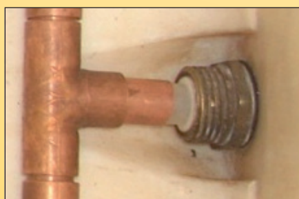
Conexión entre chupapalmer y válvula de salida
